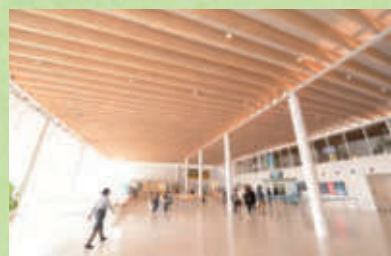
富士山静岡空港 新国内線ターミナル 県産材の梁が外部のひさしまで伸びるデザイン。天竜杉と共に、大井川の木も使用されています。
